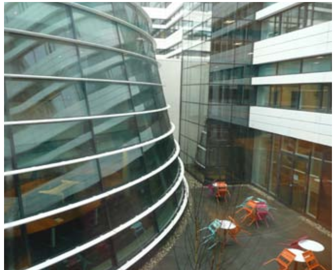
Het provinciekantoor Noord-Holland in Haarlem is in 2012 verduurzaamd van label G naar A ++ .
