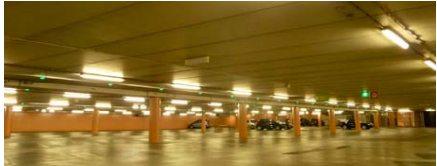
De gemeente Nijmegen investeerde bij deze parkeergarage € 38.000 in energiezuinige verlichting. Het levert jaarlijks € 30.000 op.
