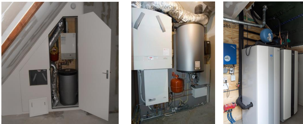
figuur 10: cv-installatie met zonneboiler bij Binnengasthuisstraat en Sleephelling, toepassing warmtepompen bij Poorterstraat
