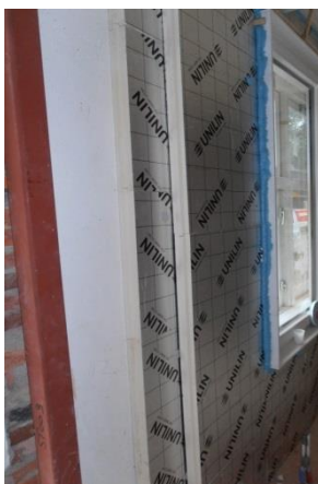
Figuur 4: voorbeelden binnengevelisolatie Binnengasthuisstraat Zwolle
