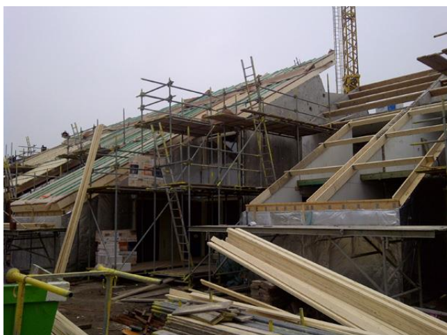
Figuur 8: voorbeeld nieuwe dakconstructie (Montfoort)
