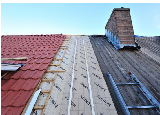
Figuur 7: voorbeeld dakisolatie buitenzijde- en binnenzijde
