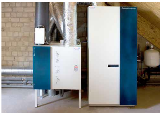
figuur 11: cv + WTW-unit De Kroeven
