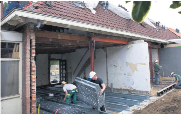
Figuur 2: nieuwe geïsoleerde betonvloer in bestaande woning
