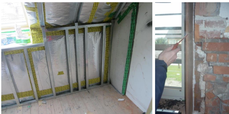
figuur 9: luchtlekken in de praktijk
