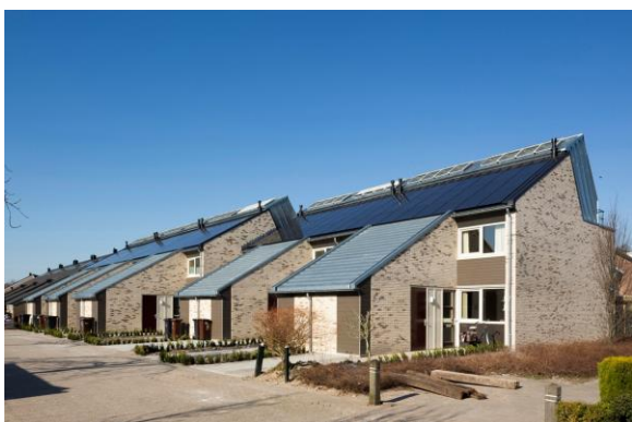
Figuur 19: Active House renovatie Montfoort
