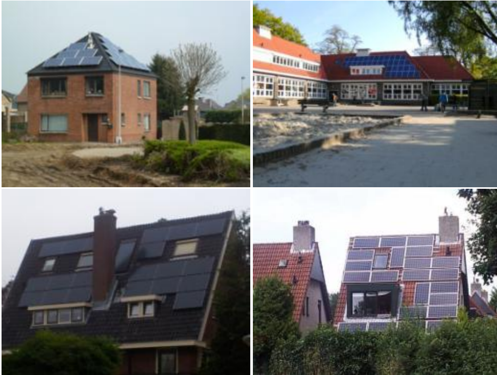
Figuur 1: Voorbeelden van inpassing van zonnepanelen op een bestaand schuin dak, waarbij de invloed van diverse belemmeringen in het dak zichtbaar wordt (foto's Flip ten Cate, Thijs Kurstjens).
