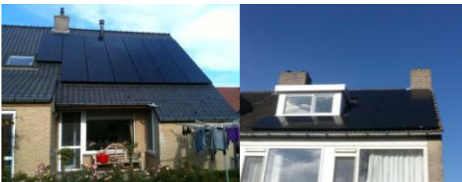
Figuur 6: Voorbeelden van daken met zg. "all black" panelen, in de uitvoering op basis van kristallijn silicium (links) of dunne-laag CIGS zonnecellen (rechts).
