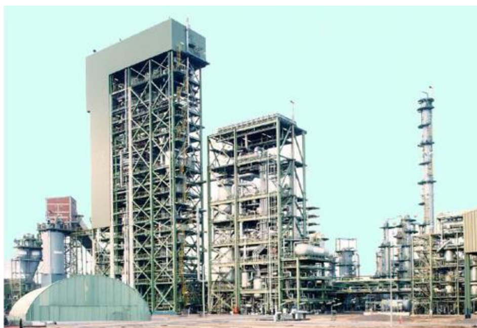
Figuur 4 De HT Winklervergasser met 300 ton/dag methanolfabriek in Berrenrath
