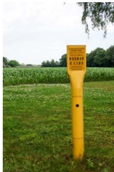
Figuur 4-2 Beeld van een gas- of waterstofleiding in de gebruiksfase
