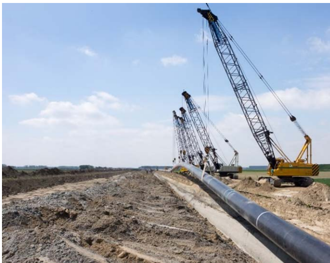
Figuur 3-8 Foto van een leiding in open ontgraving
