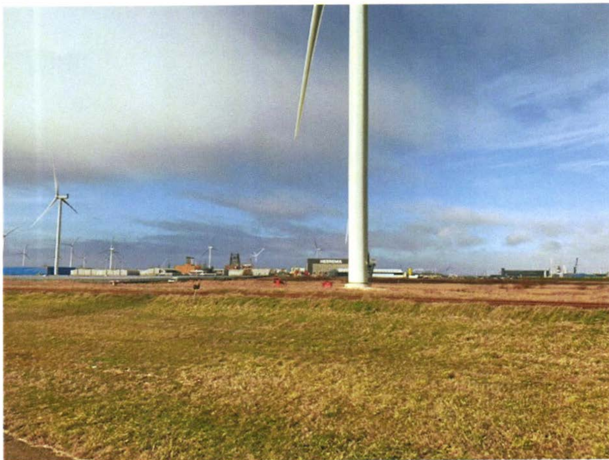
Situatie zonnepark en windturbine's ENZEE (februari 2023).
