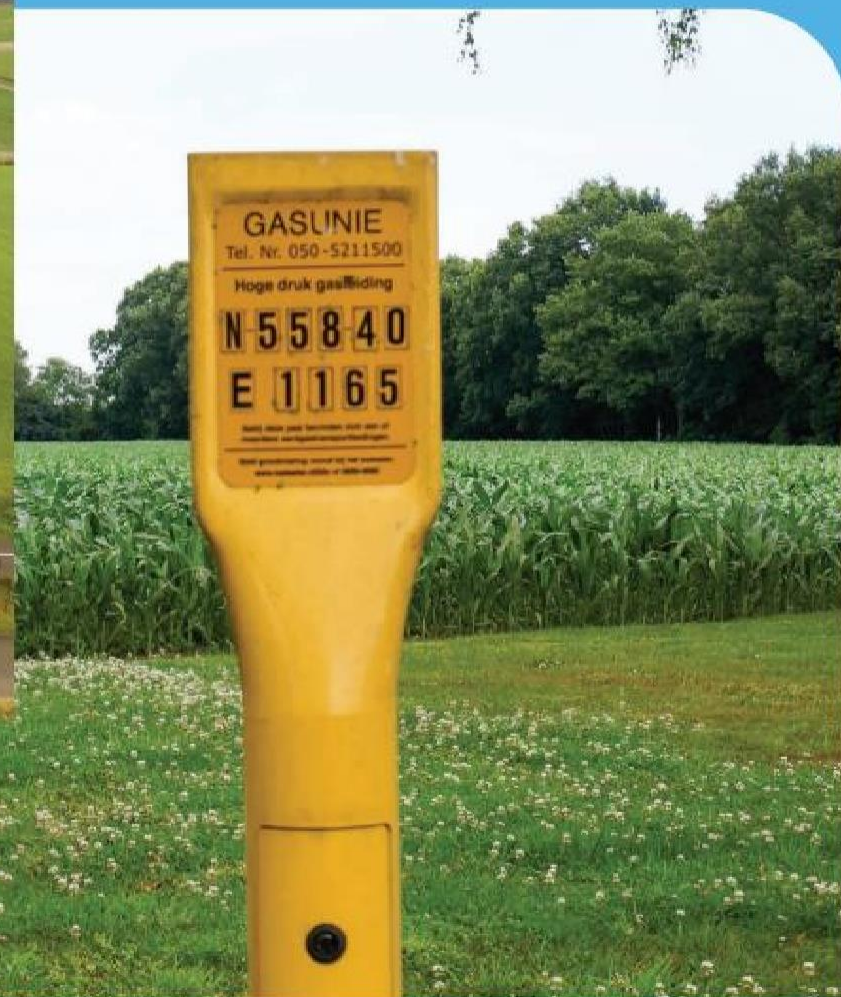
Gasunie-paaltje in landschap na aanleg leiding
