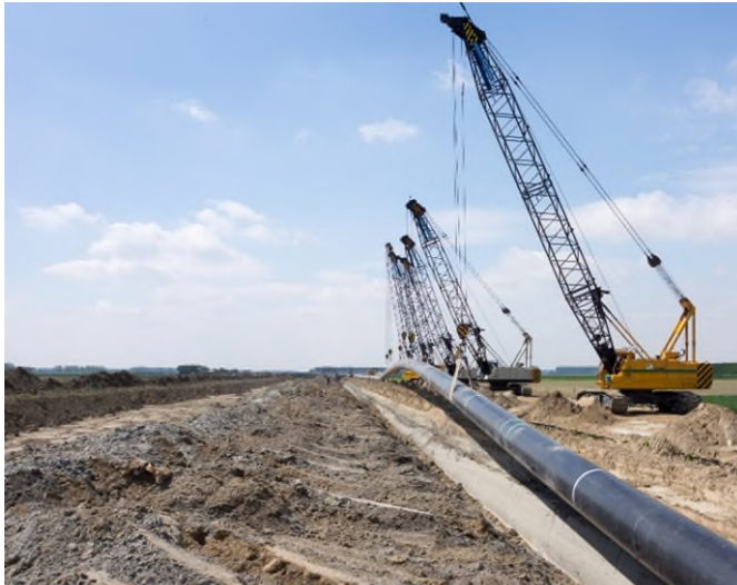
Figuur 3-8 Foto van een leiding in open ontgraving
