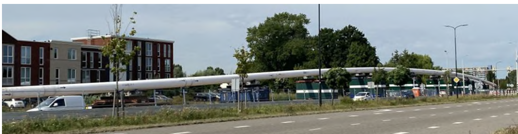
Figuur 3-9 Foto van een leiding die klaarligt voor een gestuurde boring
