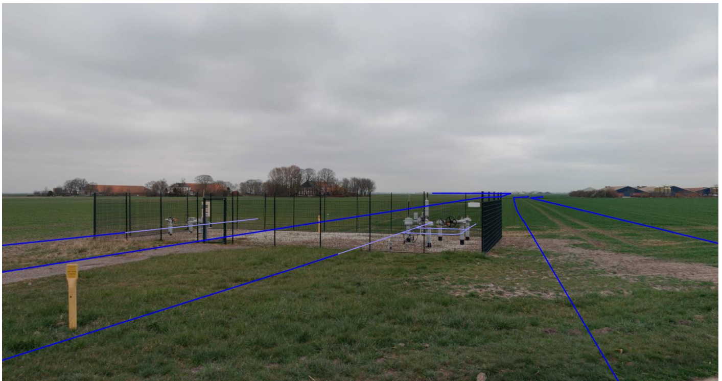
Figuur 3-1 Voorbeeld bestaande afsluiterlocatie voor aardgas S-135 Oostwold. De blauwe lijnen geven aan waar ondergronds de aardgasleidingen liggen
