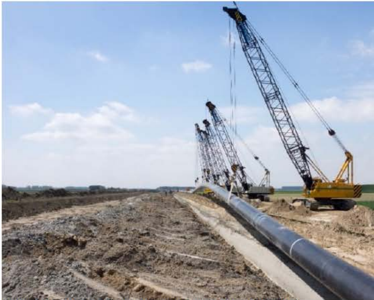
Figuur 3-8 Foto van een leiding in open ontgraving (bron: HNS, 2022)
