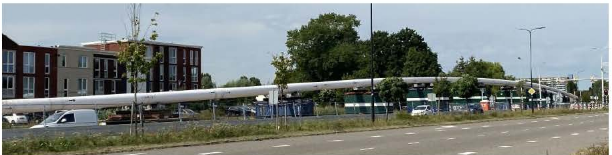
Figuur 3-9 Foto van een leiding die klaarligt voor een gestuurde boring (bron: HNS, 2022)
