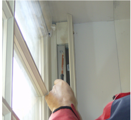
Figuur 2 Visueel testen van de luchtdichtheid met een rookpatroon, waarbij de woning op onderdruk is gebracht; woningbouwcomplex Justus van Effen
