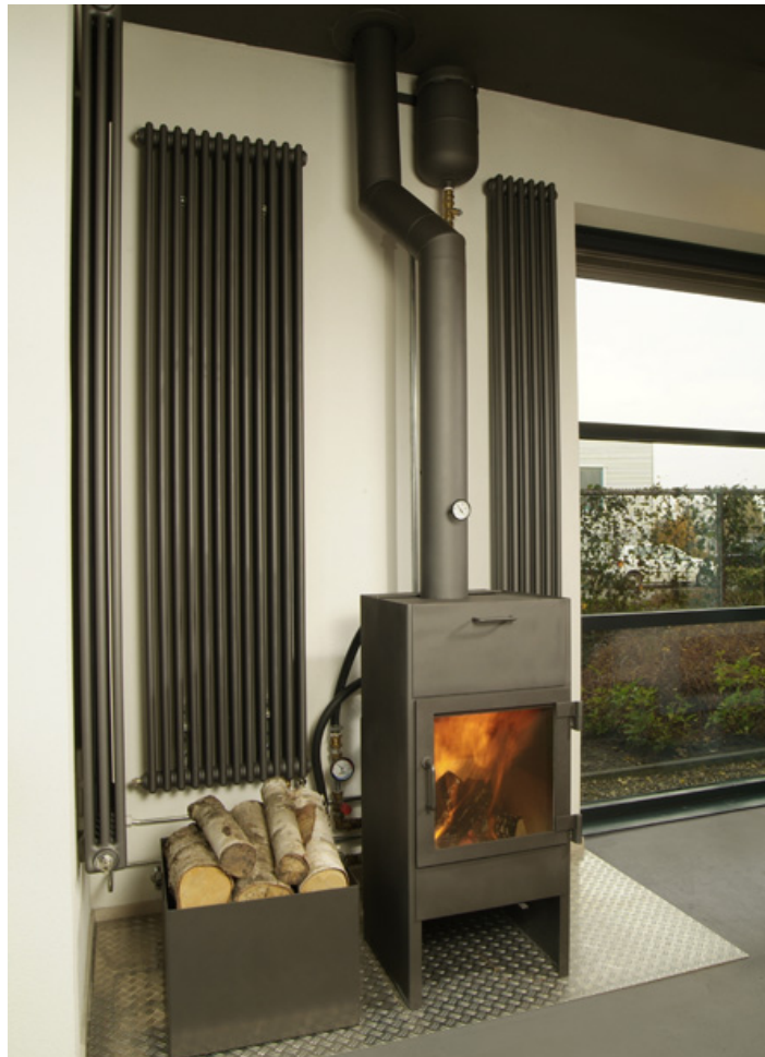
Figuur 3.6 Voorbeeld van een stukhoutgestookte kachel met CV-koppeling (Dik Geurts)
