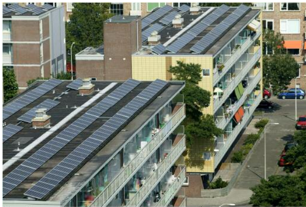
Den Haag, Vestia, PV op bestaande flats.
