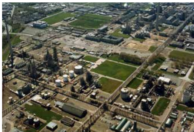
Stoomleidingen op het Chemelot terrein (Foto: USG)
