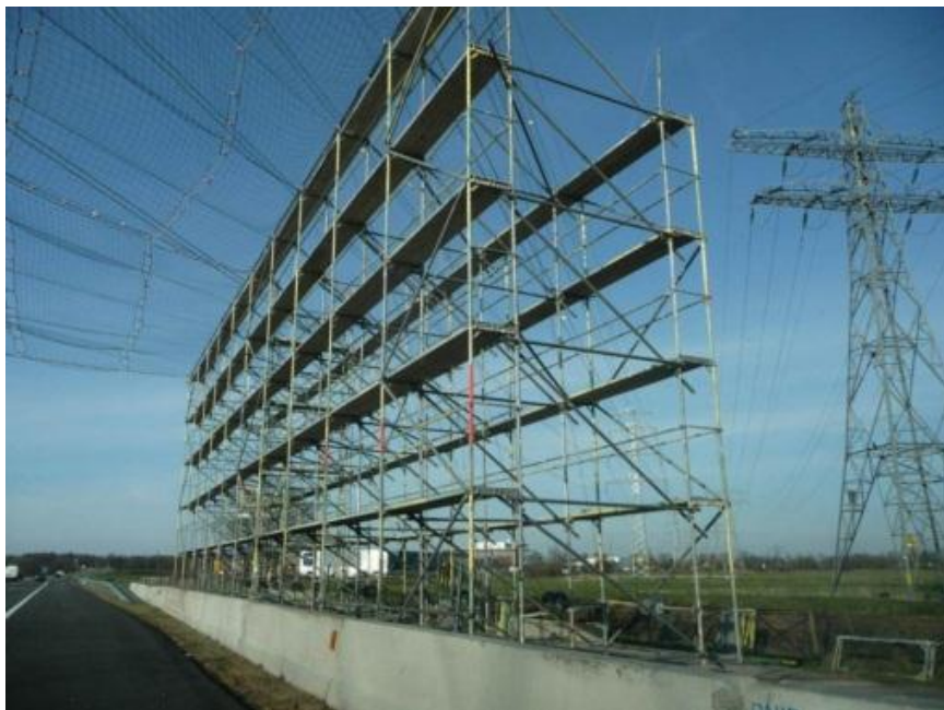
Figuur 2: voorbeeld van een juk met vangnet.
