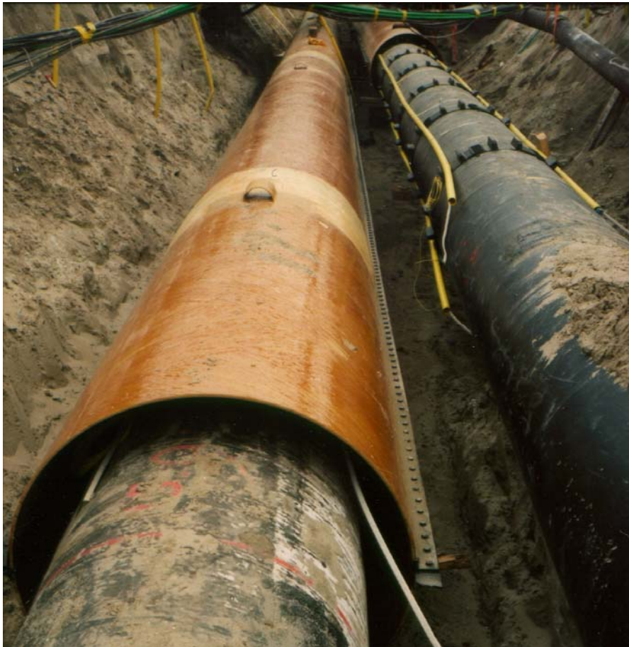
Fig. 13.4.1 Deelbare mantelbuis, waarbij rechts de afstandhouders te zien zijn.
