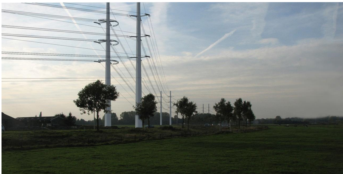
Figuur 136 Middengebied Ulft-Silvolde (locatie 8, kijkrichting noordwest)
