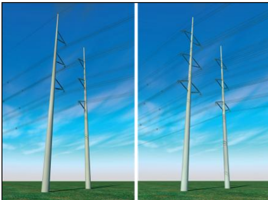
Afbeelding 6 380 kV mast (links) en combinatiemast 150 kV en 380 kV (rechts)
