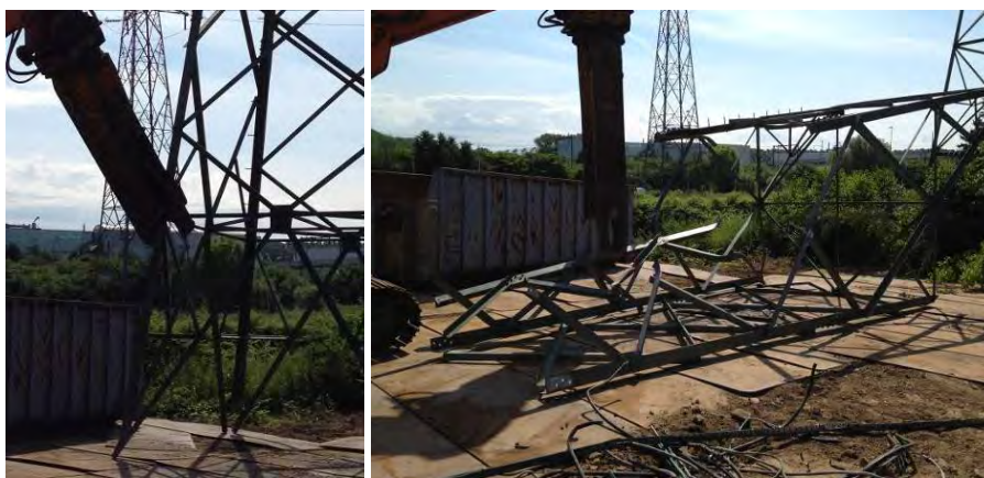
Knippen van mast elementen
