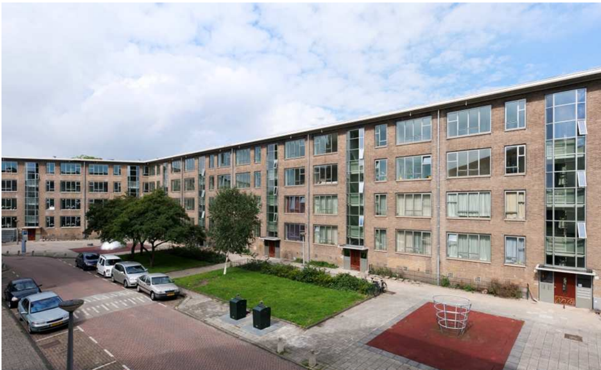
Fig. 8.10 De Koningsvrouwen van Landlust is een renovatie- en restauratieproject in de Amsterdamse wijk Bos en Lommer.
