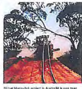
Bij het Murraylink project in Australië is een zeer succesvolle en eenvoudige methode toegepast waarbij gebruik gemaakt wordt van aangepast materiaal uit de glasvezelindustrie.
