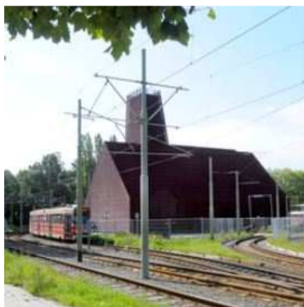
Figuur 5. Een ketelhuis met twee ketels in een woonwijk in Den Haag.
