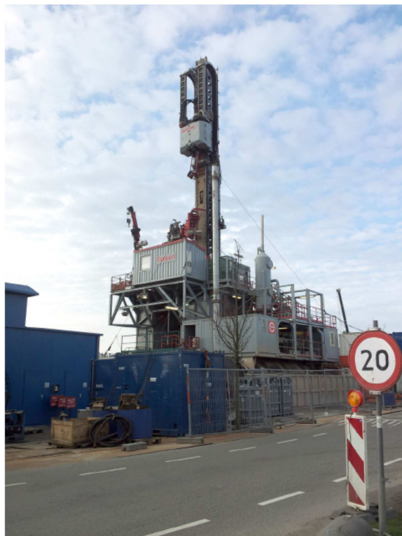
Figuur 17. Boortoren voor de aardwarmteboring in Honselersdijk.
