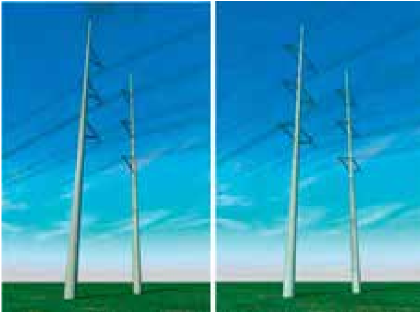
Figuur 12 380kV solomast (links) en combiniemast 150kV en 380kV (rechts).
