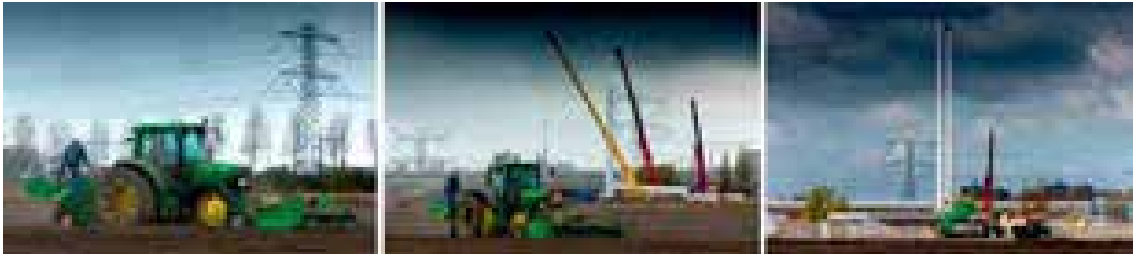
Foto 2 Het bouwen van een mast.
