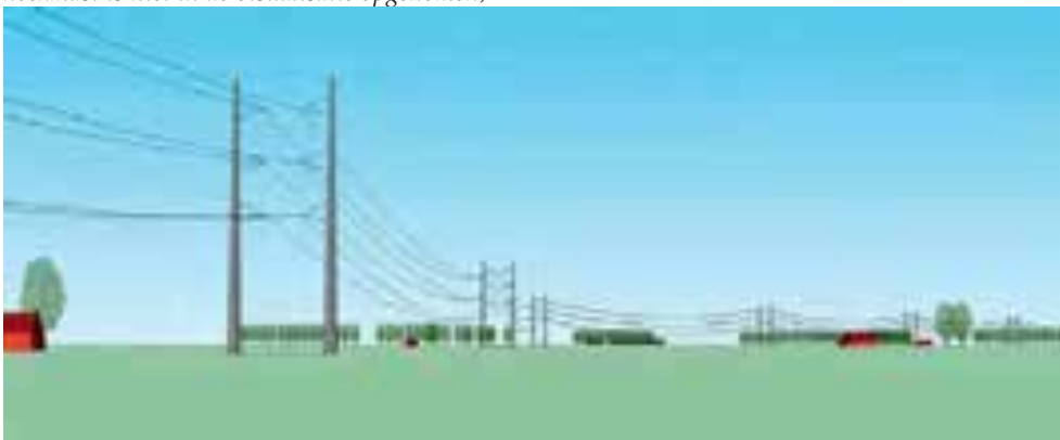
Lijn met een richtingsverandering van 40 graden (nb de afwijkende mastvorm van de hoekmast is niet in de visualisatie opgenomen). Het aanzienlijk verschil in beeld aan beide zijden van de knik is een duidelijk waarneembare verstoring van het rustige ritme van de lijn. Er ontstaat een visueel meer complexe situatie.
