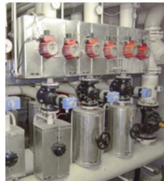
Figuur 3: aluminium beplating. Bron: Thermatras.
