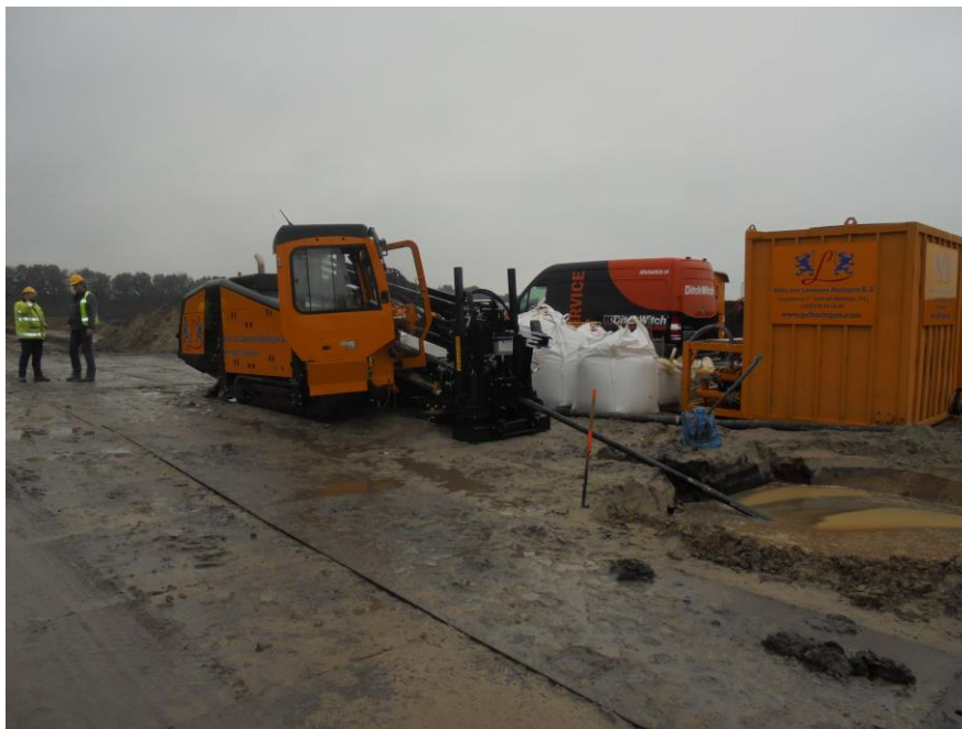
Foto 1: Booropstelling ten behoeve van een gestuurde boring
