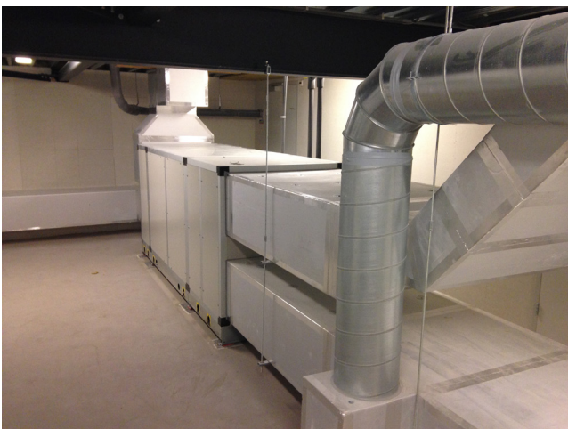
centrale luchtbehandingskast
