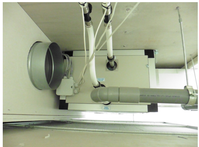
decentrale luchtbehandelingsunits lokalen
