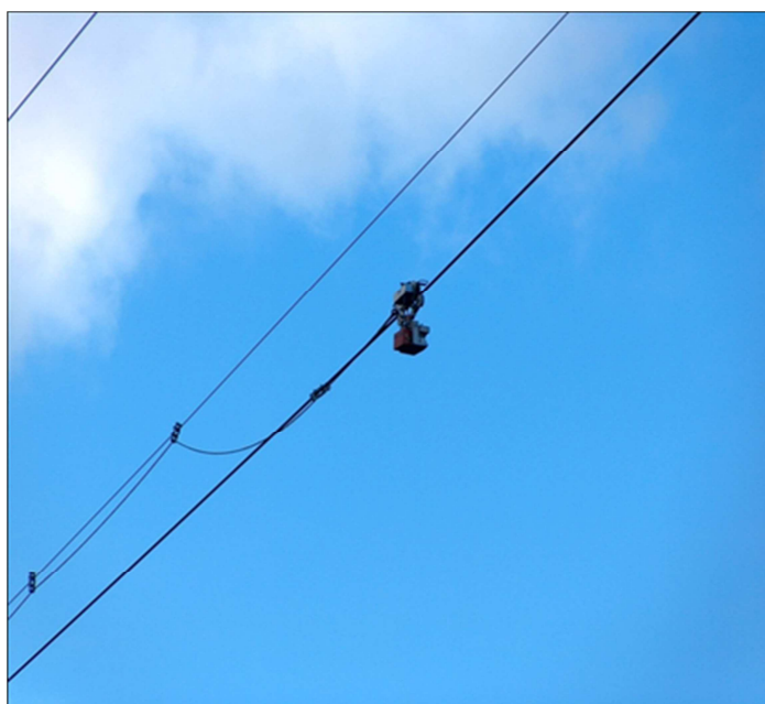
Figuur 7 Loopkat op een andere hoogte dan de te trekken geleider
