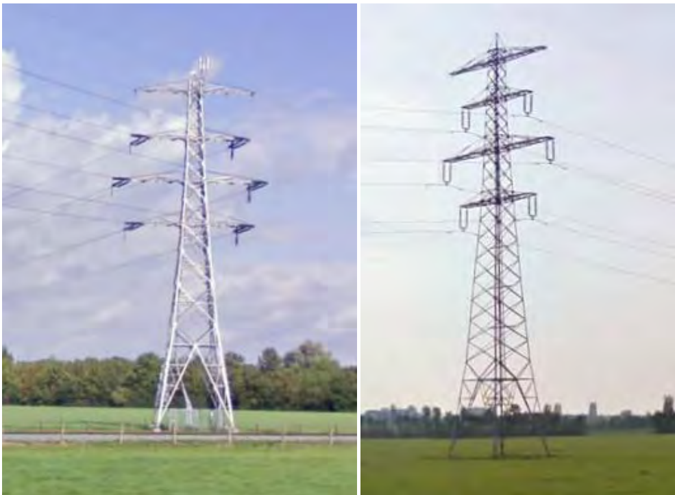
Afbeelding 16 De huidige situatie met de 150 kV-hoogspanningslijnen bij Zevenaar (links) en Ulft (rechts). Twee circuits van drie enkele geleiders met bovenaan twee bliksemdraden.
