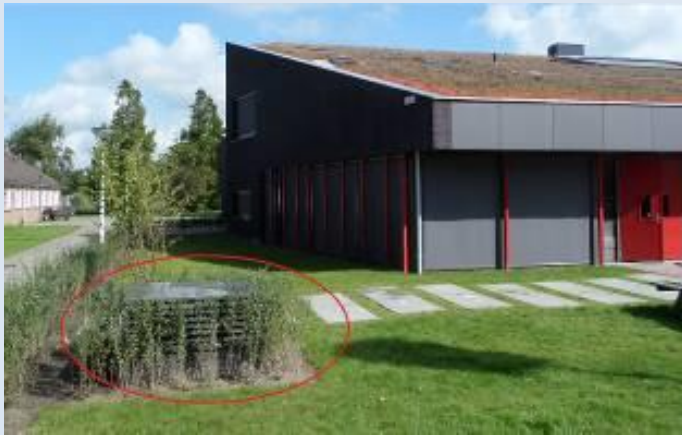
Eén van de twee aanzuigroosters van het grondbuissysteem
