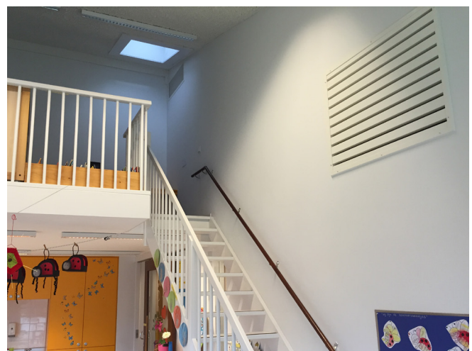
Rechts in de wand een groot rooster van het BaOpt-systeem
