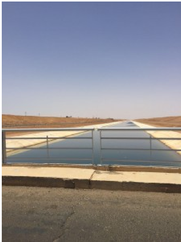
Irrigatiesysteem in landreclamatiegebied
