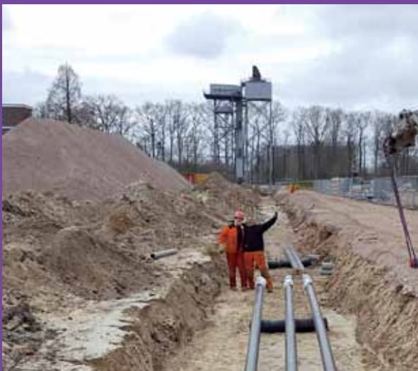
Aanleg van warmteleidingen op het HTSP-terrein in Hengelo.
