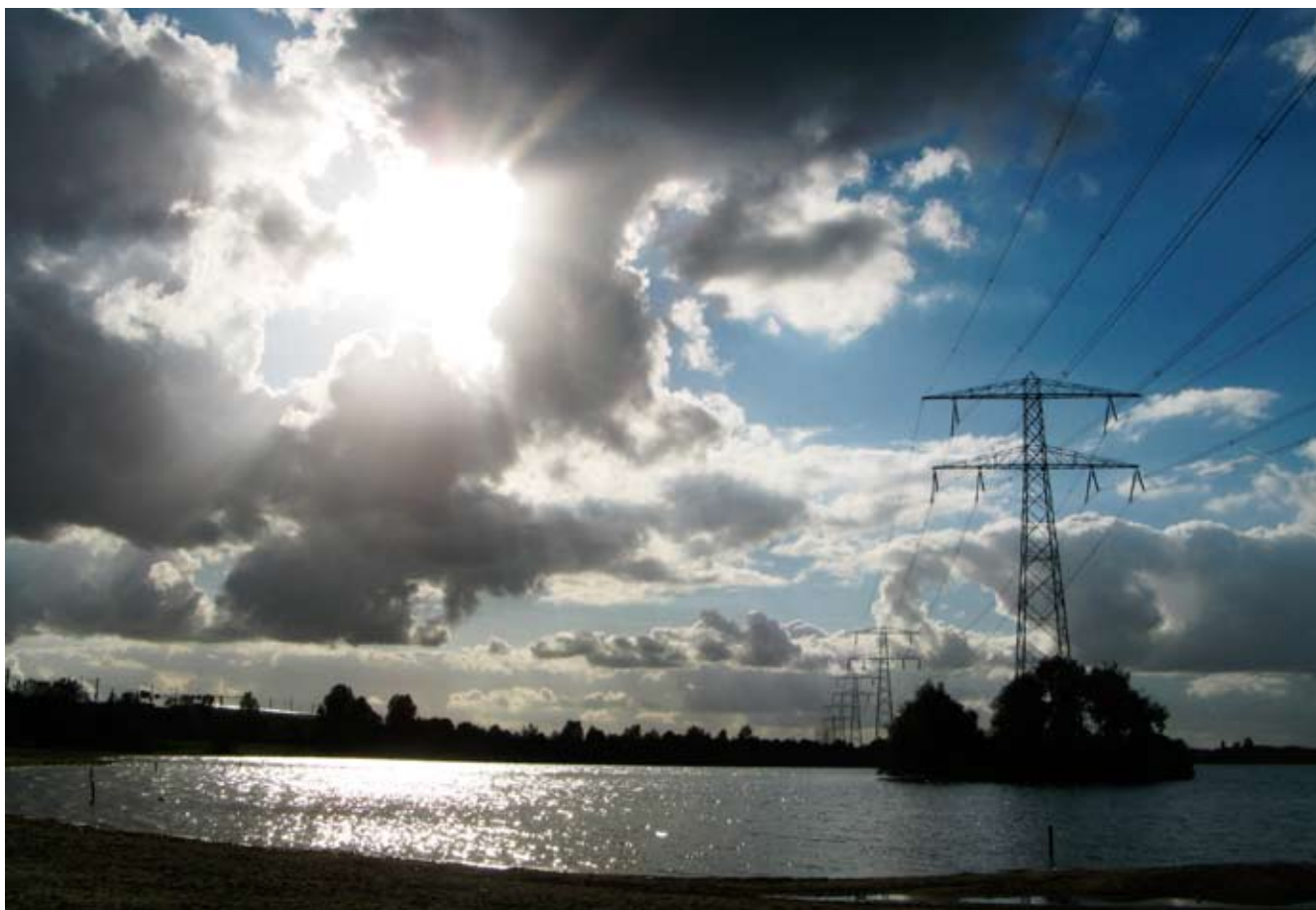
Afbeelding 5.2 De 380 kV verbinding bij Hollandse brug
