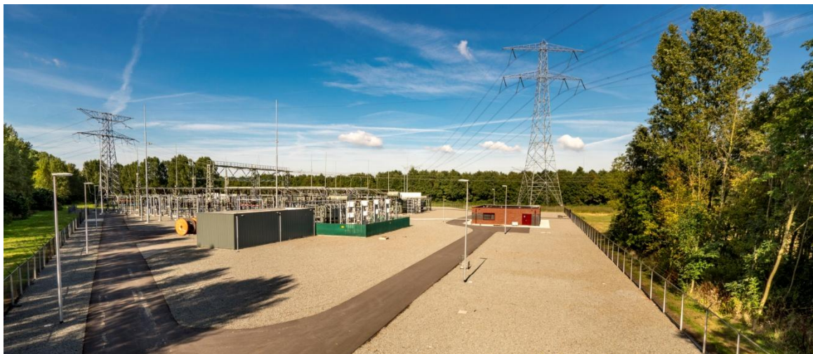
Afbeelding 6.9 Referentiebeeld van een bestaand transformatorstation
