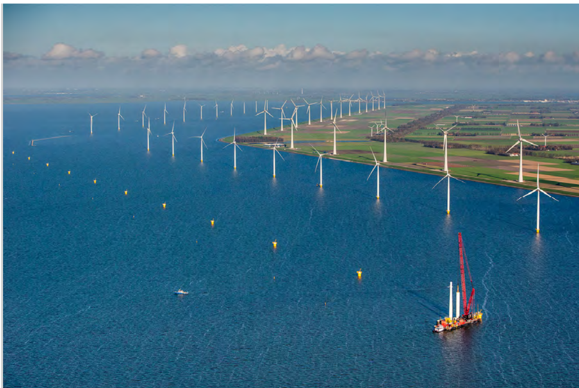
Afbeelding 2.9 Windpark Noordoostpolder tijdens de bouw. De windturbines in het water hebben hier een ashoogte van 95 m met een tiphoogte van 148,5 m. De landturbines hebben een ashoogte van 135 m en een tiphoogte van 198,5 m
