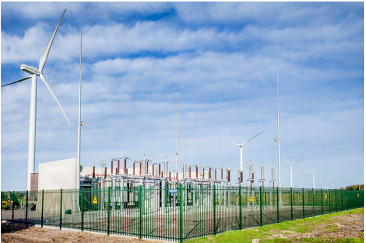
Afbeelding 5.22 Voorbeeld van een onderstation
