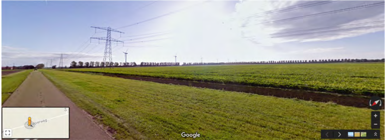
Afbeelding 5.24 Locatie 2, gezien vanaf de Visvijverweg
