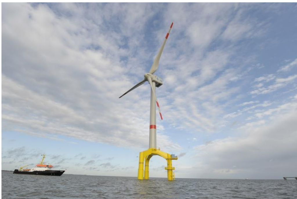
Figuur 2.5 Voorbeeld van een tripile fundatie 2 .
