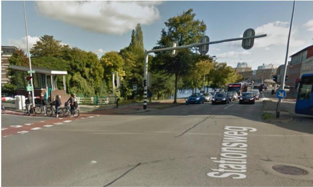
Figuur 6-1: Een VRI portaal met een enkele paal en grote uitkraging
