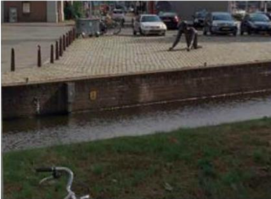
Figuur 5-1: Gemetselde kademuren in Groningen (Winschoterkade-Oosterkade).
