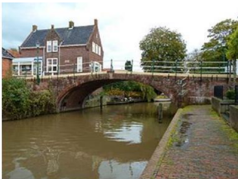
Figuur 8-2: Metselwerk boogbrug
