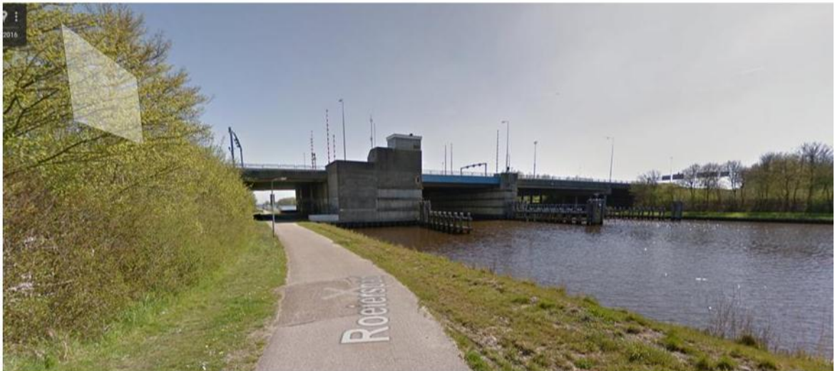
Figuur 8-4: Voorbeeld van een basculebrug
