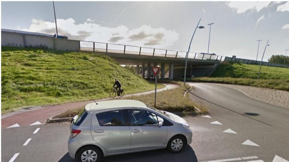
Figuur 8-1: Viaduct in de A7 met een betonnen dek, hooggelegen landhoofden en één tussensteunpunt
