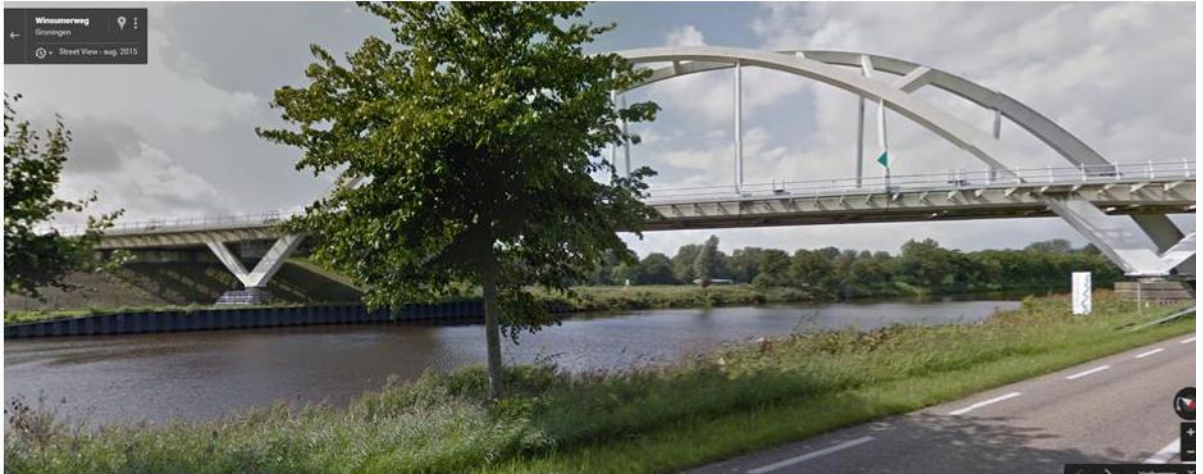
Figuur 8-10: Spoorbrug Van Starckenborghkanaal
