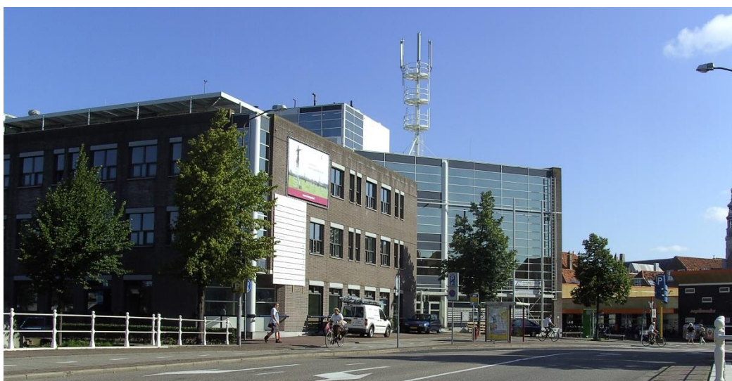
Koestraat (linker gebouw)
