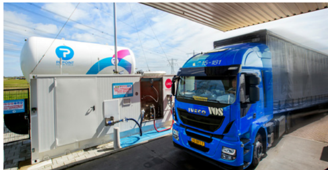
Het waterstof-tankstation van PitPoint (foto: PitPoint)
