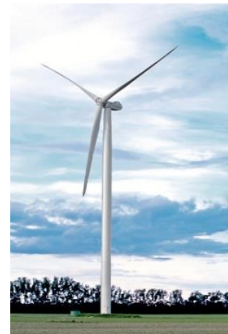
Figuur 2.2 Voorbeeld turbine Nordex N149, 4,5 MW
