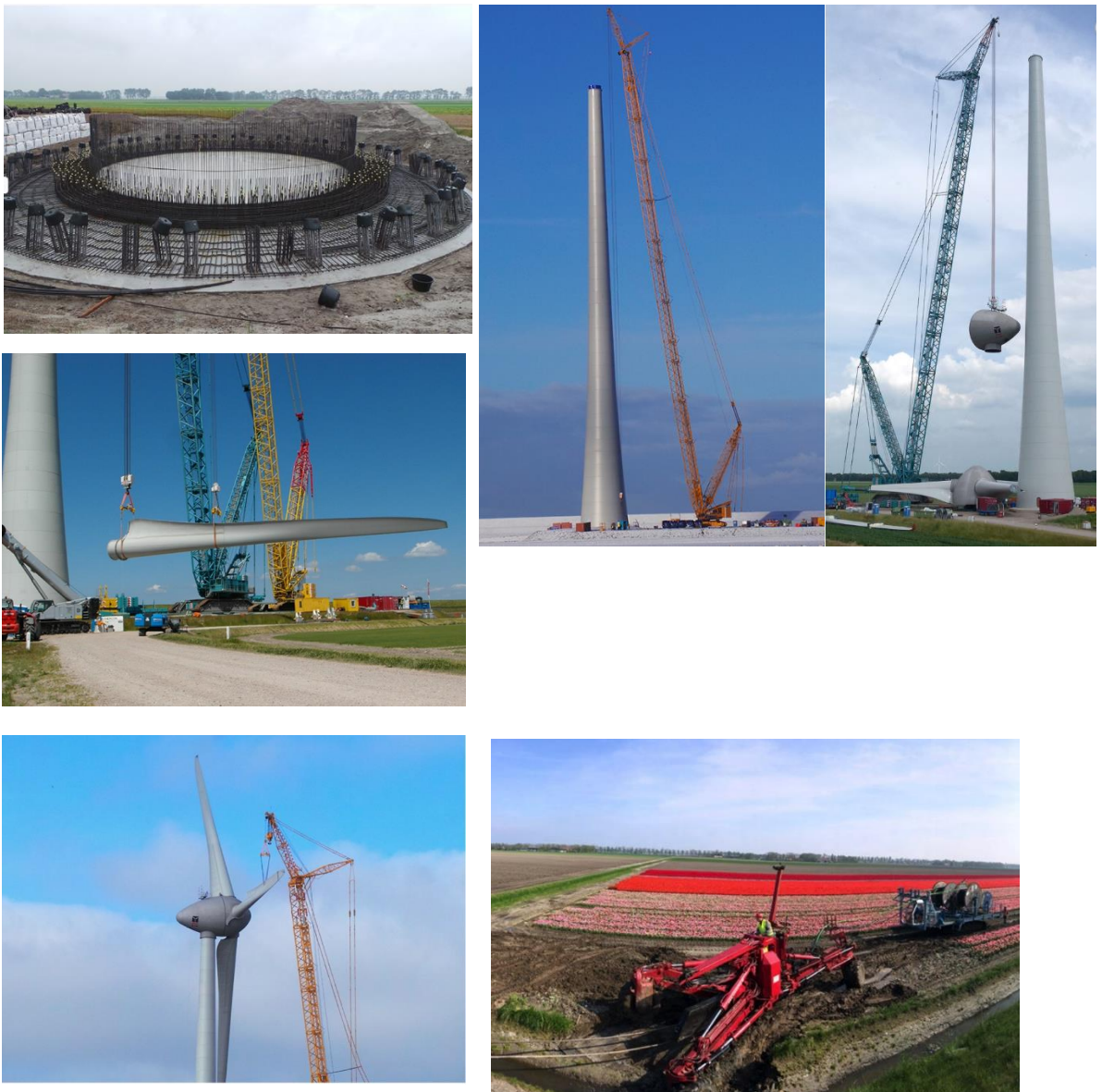
Figuur 2.4 Beelden bouw windturbine en kabelploeg (windpark NOP Agrowind)
