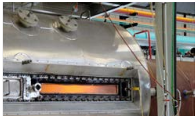
Proefopstelling industriële ketel
