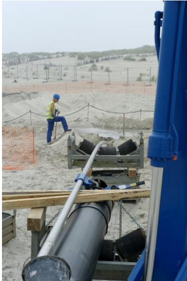
Afbeelding 3.10 HDD boring duinen (TenneT Duitsland)
