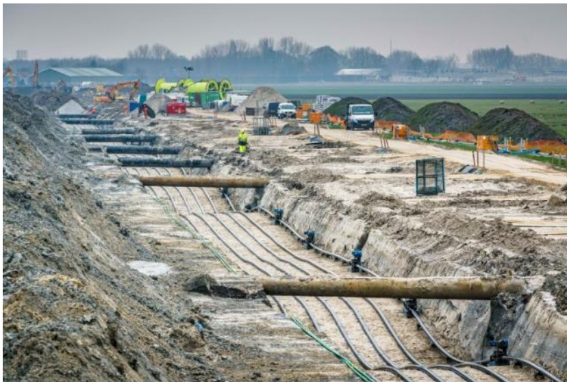
Afbeelding 2.2 Voorbeeld van een sleuf waar de kabels worden neergelegd
