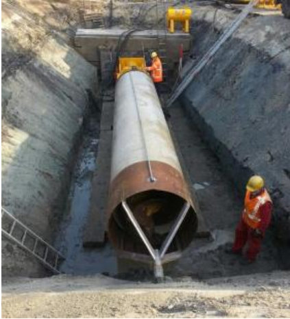
Afbeelding 2.4 Gesloten front boring techniek
