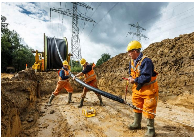
Afbeelding 1.7 Voorbeeld van de aanleg van kabels in een open ontgraving
