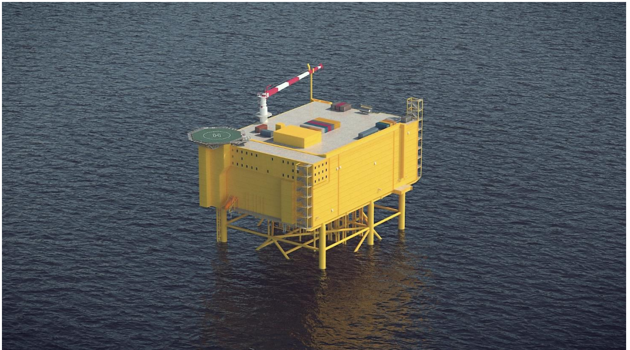
Figuur 1-3 Artist's impressions van een 2 GW platform voor IJmuiden Ver (met een stalen draagconstructie)
