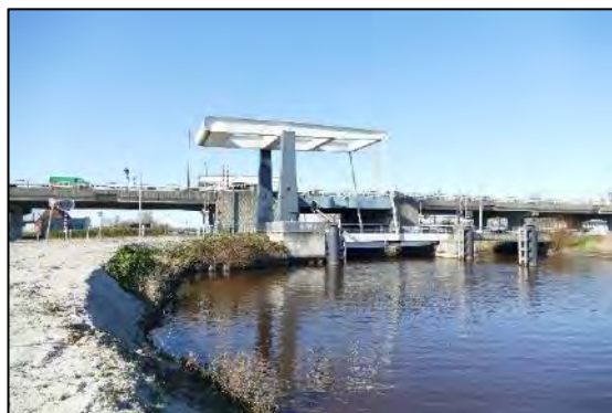
Afbeelding 3.22. Brug A7 over het Winschoterdiep.
