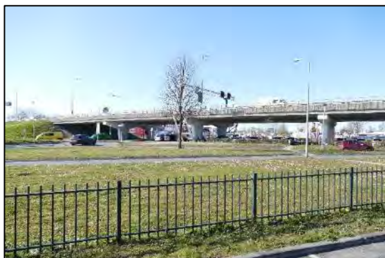
Afbeelding 3.21. Viaduct A7 over Bornholmstraat.
