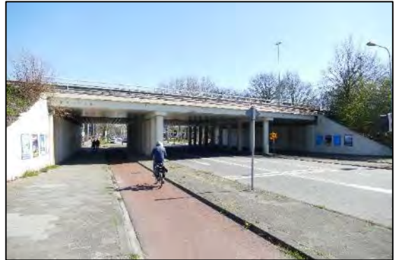
Afbeelding 3.12. Viaduct A28 over Van Ketwich Verschuurlaan.
