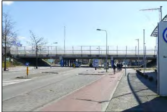
Afbeelding 3.7. Viaduct A7 over Paterswoldseweg.
