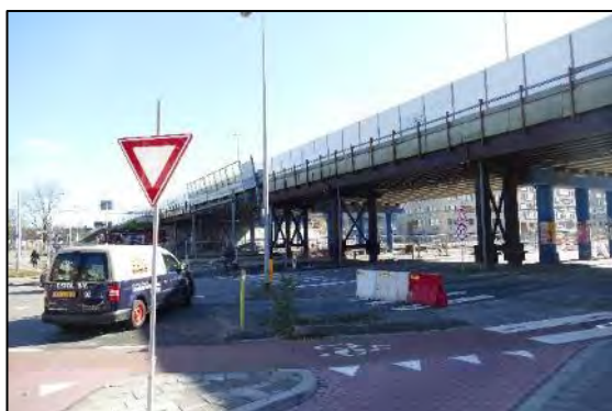
Afbeelding 3.17. Viaduct A7 Helperzoom.
