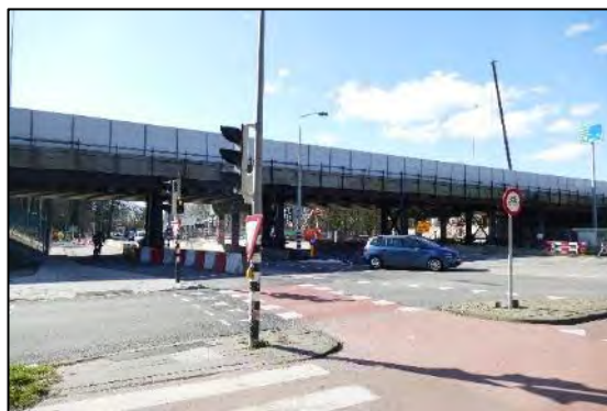
Afbeelding 3.16. Viaduct A7 over Hereweg.
