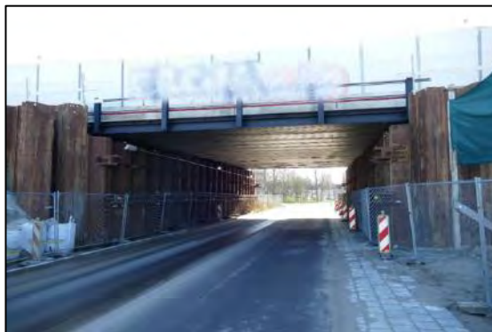
Afbeelding 3.9. Viaduct A28 over Brailleweg.
