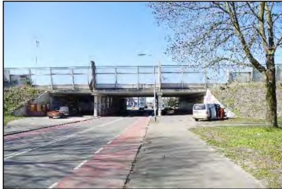
Afbeelding 3.11. Viaduct A28 over Van Iddekingeweg.
