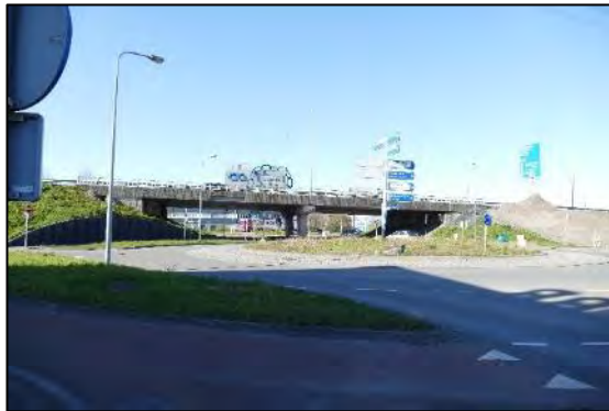
Afbeelding 3.23. Viaduct A7 over Gotenburgweg.
