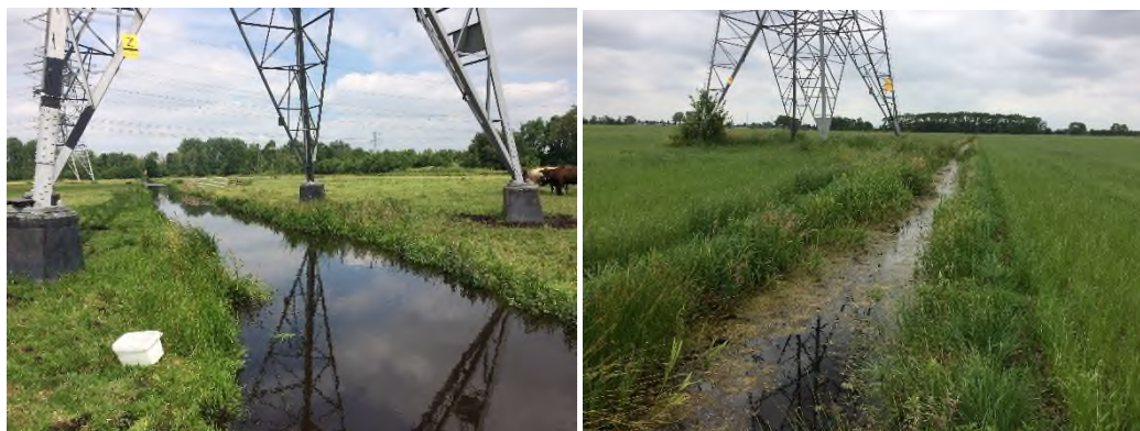
Figuur 2.1 en 2.2. De te dempen sloten bij mast 1 (links) en mast 32 (rechts).
