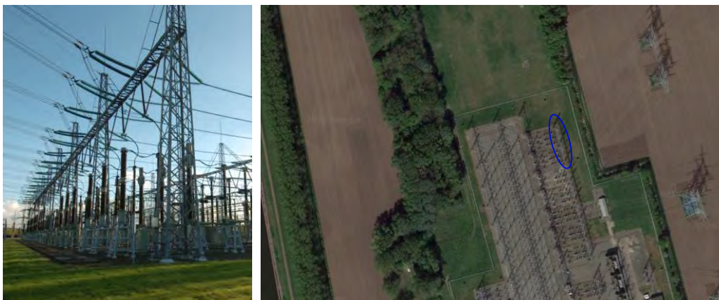
Figuur 3 Oversichtfoto's fundaties station GT (Bron foto's: TenneT en Google Maps)
