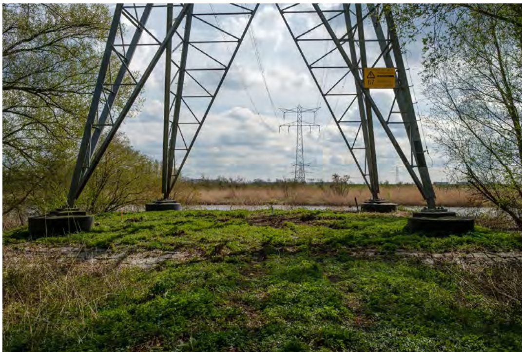
Figuur 10 Fundatie mast 67 op een terp
