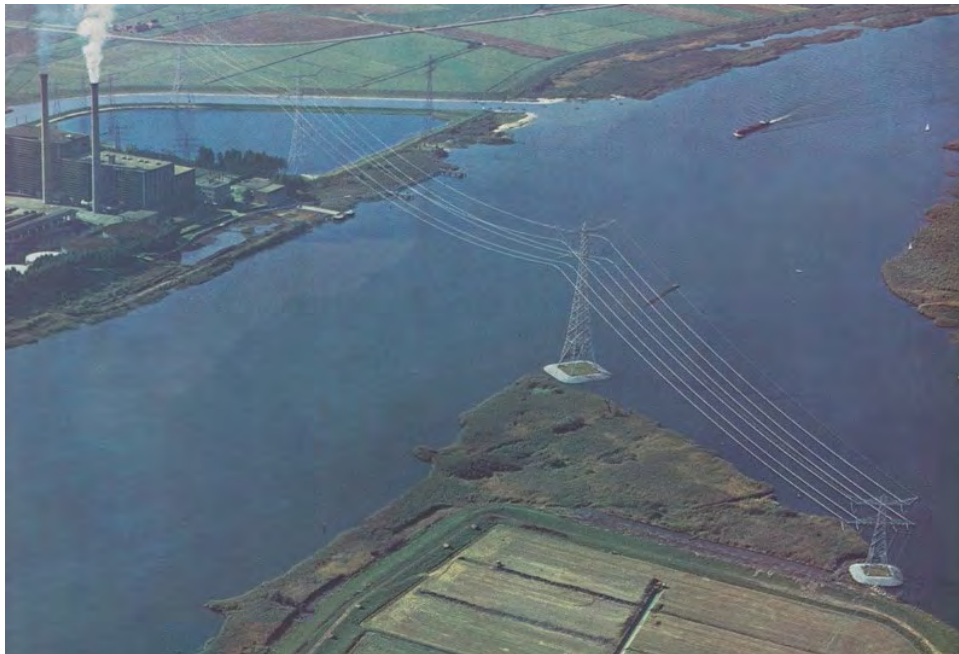
Figuur 7 Terpfundaties mast 83 en 84 (Stroom voor Nederland, 1970)
