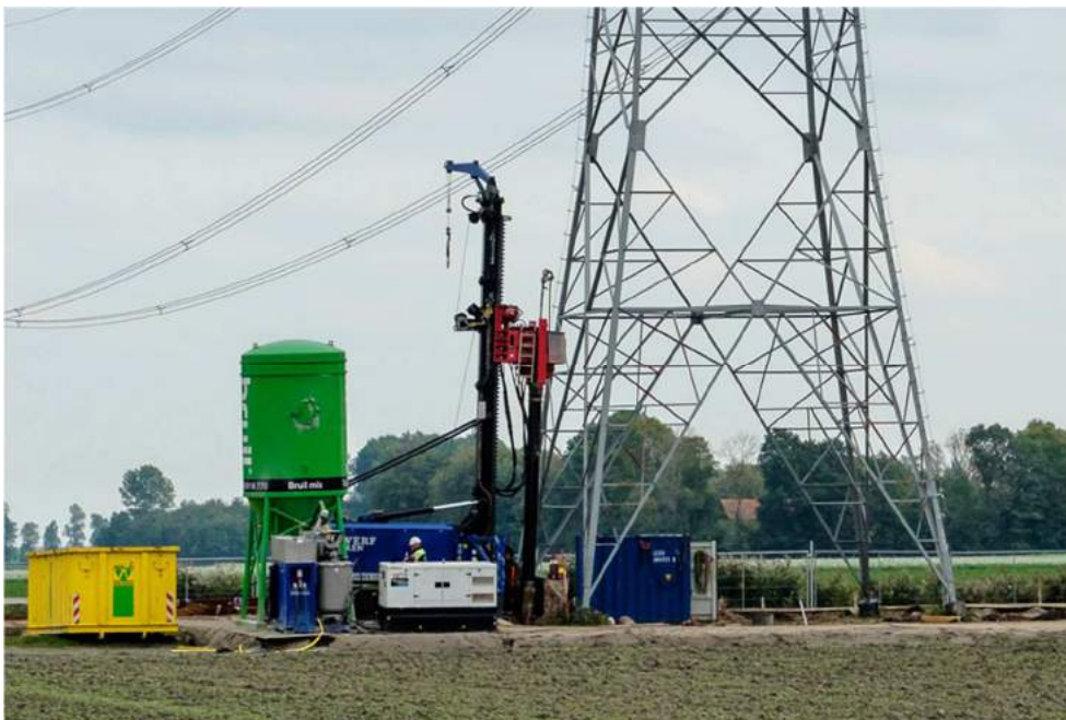
Figuur 6 Voorbeeld van heistelling voor schroefinjectiepaal
