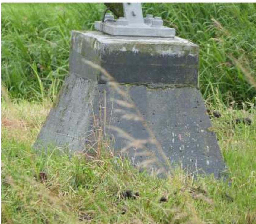
Figuur 4 Foto van fundatiepoer mast 24
