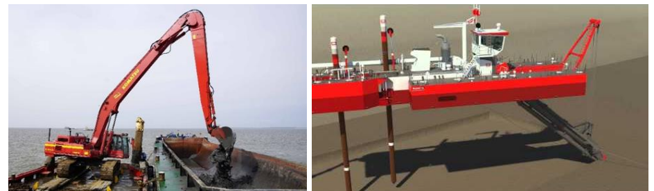
Figuur B4 – Links: Baggeren met graafmachine Rechts: Snijkopzuiger
