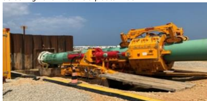
Figuur B19 - DGB-G techniek toegepast Hak project in Israël, de onshore locatie (A. Hak)
