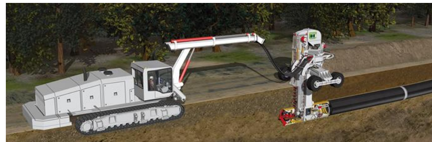
Figuur B2 - Pipe Express®-Systeem
