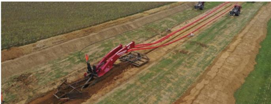
Figuur B1 - Methode ploegen
