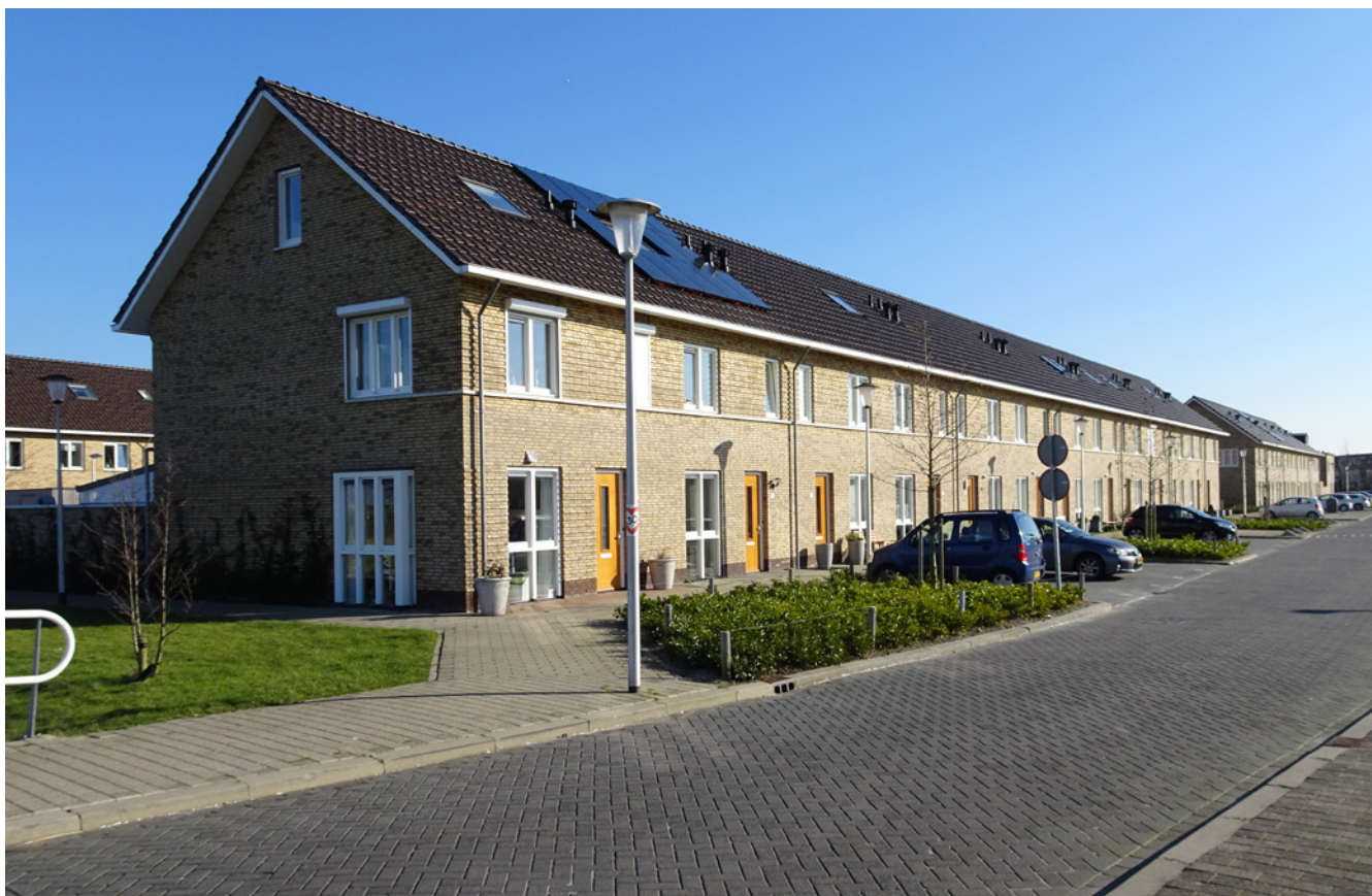
De proefwoning in Berkel en Rodenrijs heeft een bodemlus onder het plantsoen direct voor het huis, zonnepanelen op het dak en een compact warmtepompsysteem in de woning.
