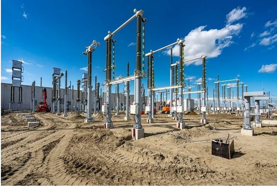
Figuur 2.14 Voorbeeld veld in aanbouw
