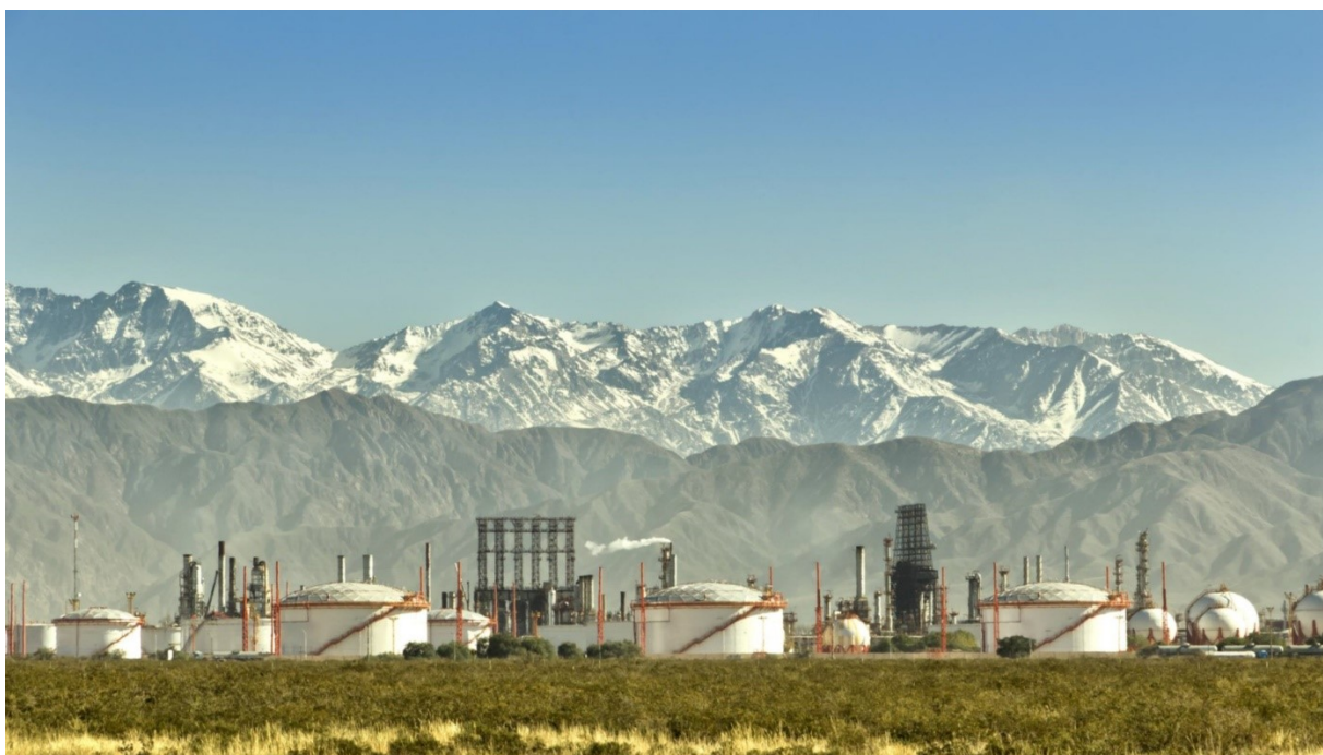
Refinery of YPF in Mendoza, Argentina. Source: Agencia Argentina de Inversiones y Comercio Internacional
